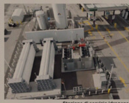
Stazione di servizio idrogeno
